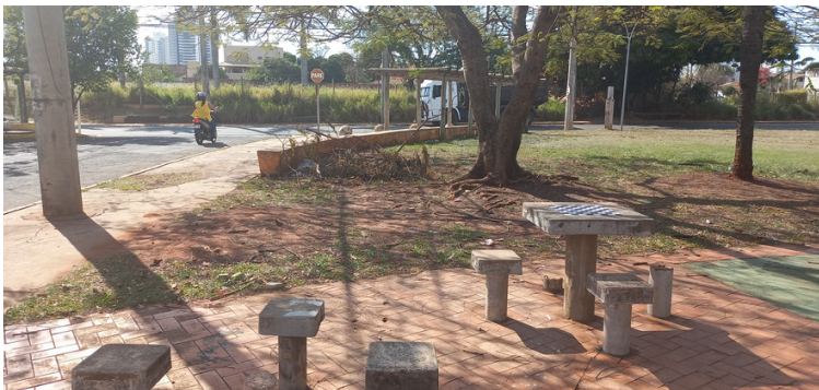
Foto 5 - Jogos de tabuleiro de concreto necessitando de conserto.
