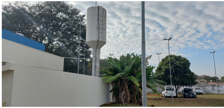
Foto 17 - Caixa d'água em desuso.
