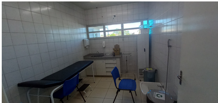
Foto 5 Sala de Curativo sem ar condicionado e ventilador.
