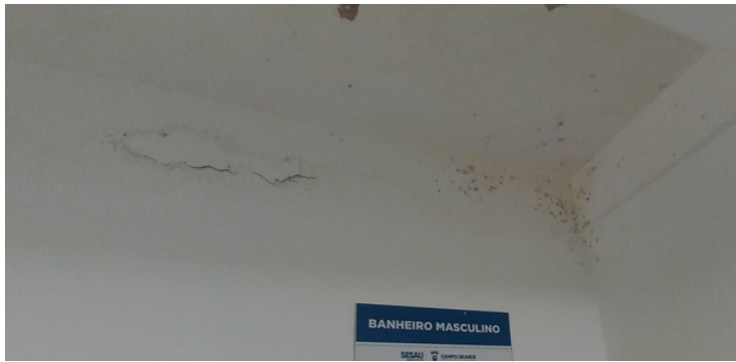
Foto 3 Teto da recepção carecendo de pintura.
