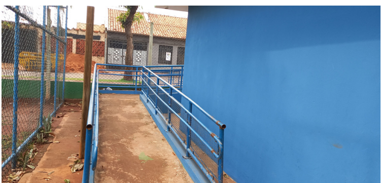
Foto 7 - Rampa de acesso para cadeirantes.
