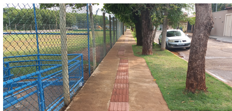
Foto 8 - Calçamento ao entorno da praça com piso tátil e adequadamente nivelada.
