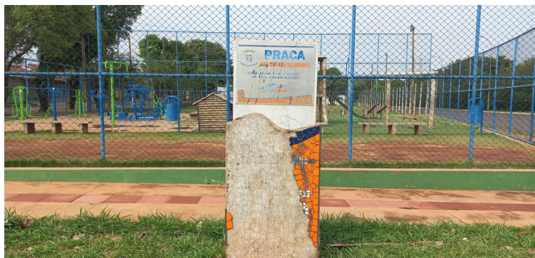
Foto 1 - Monumento da Praça José Santana Delmondes - Jardim Bonança, necessitando de manutenção.
