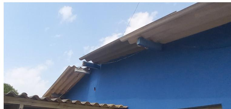
Foto 8 Telhado precisa de reforma para troca de telhas quebradas.
