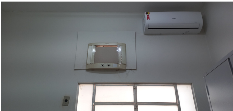
Foto 3 Salas e consultórios devidamente climatizadas
