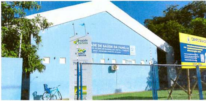
Foto 1 - Fachada da UBSF Drº Emílio Alencar Garbeloti Neto
