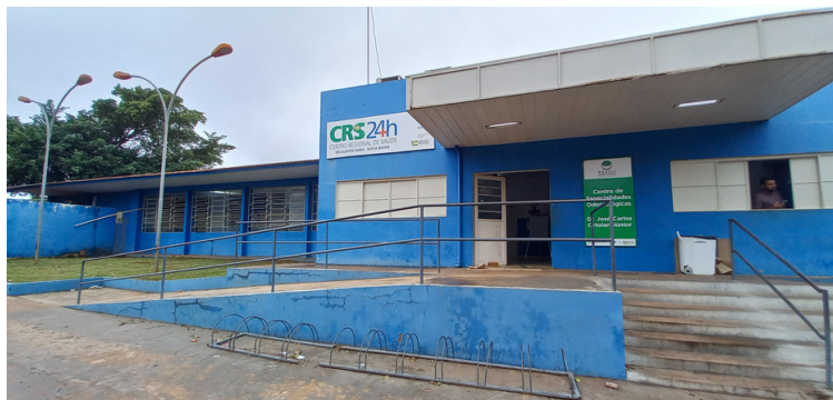
Foto 1 - Fachada do Centro Regional de Saúde CRS Dr. Guinter Hans - Nova Bahia.
