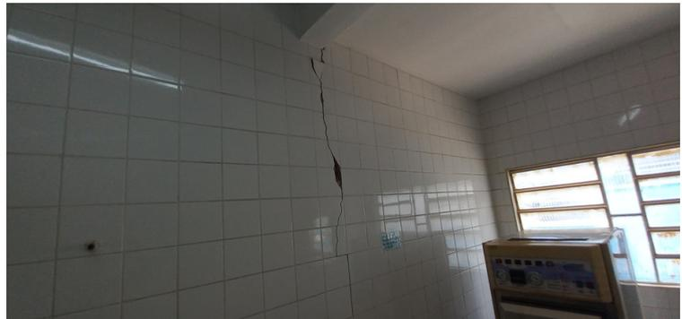
Foto 6 - Sala de esterilização com extensas fissuras e rachaduras.
