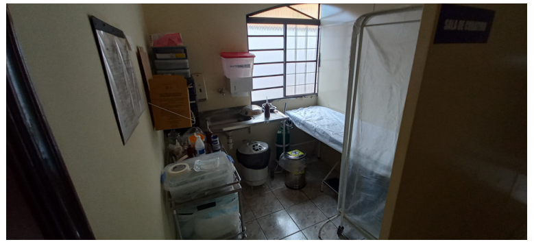
Foto 2 - Sala de curativo sem adequada climatização.
