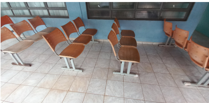
Foto 7 - Setor de espera com longarinas enferrujadas.
