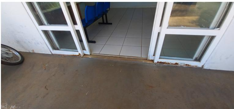
Foto 6 - Esquadrias corroídas pela ferrugem e pintura corroída.
