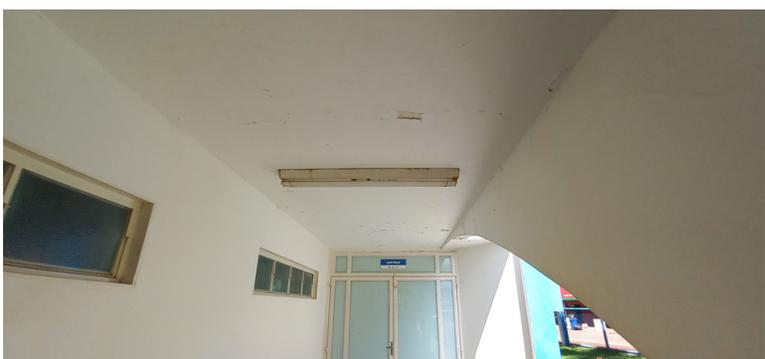
Foto 8 - A parte elétrica necessita de revisão para substituição de lâmpadas queimadas e reposição de lâmpadas faltantes.
