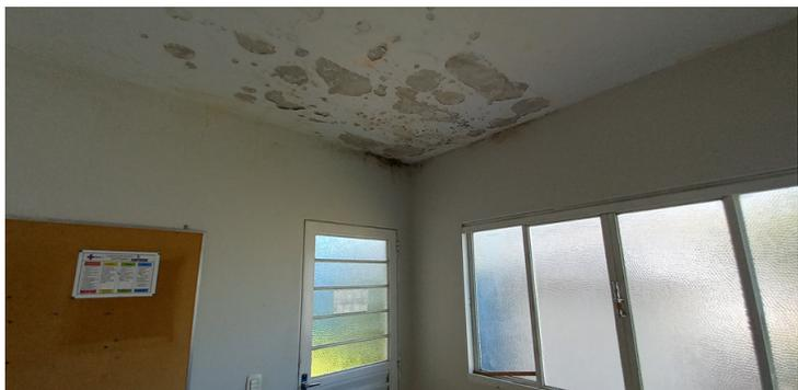
Foto 5 - Paredes da unidade com pintura descascada e mofo visíveis.
