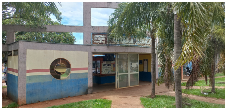
Foto 1 - Entrada principal do Terminal General Osório.
