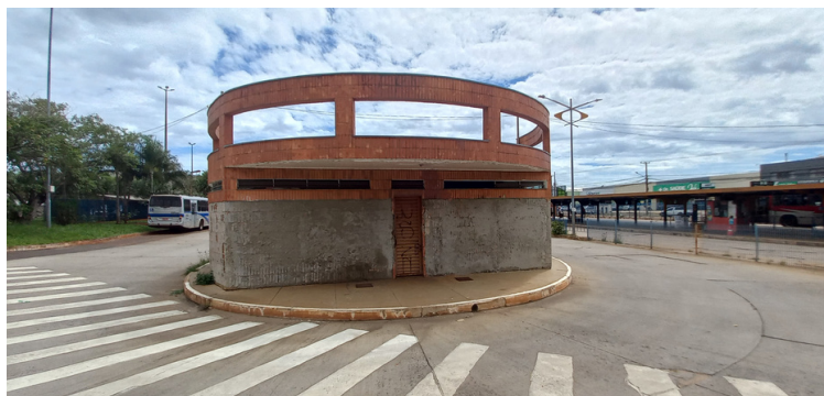
Foto 2 - Estrutura de uma das fachadas, sem revestimento.
