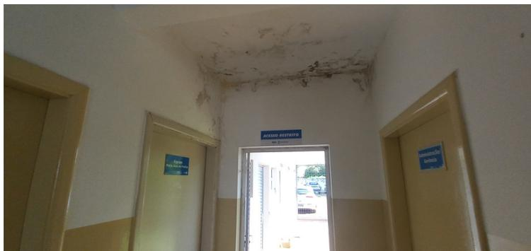
Foto 3 - Parede com infiltração e mofo visível.
