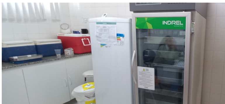
Foto 6 - Câmara fria da sala de vacinas aguardando reparo.
