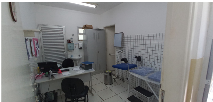
Foto 5 - Consultórios devidamente climatizados e estruturados.
