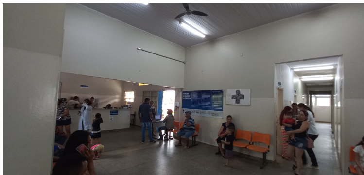
Foto 2 - Recepção sem a devida climatização.
