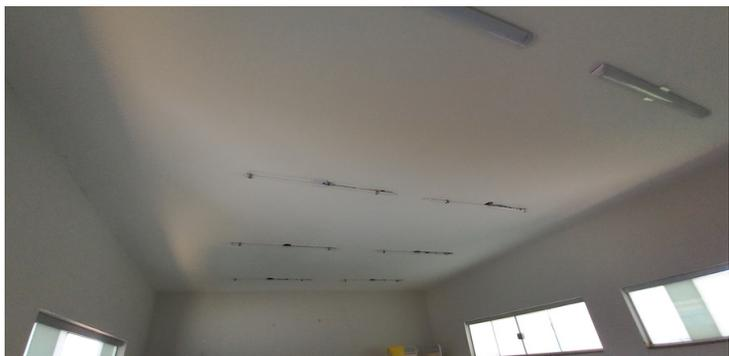
Foto 5 - É necessário revisão na parte elétrica, apresentando lâmpadas faltantes.
