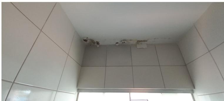
Foto 2 - Paredes com pontos de pintura desgastada e infiltração.
