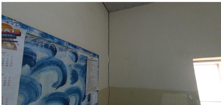
Foto 9 - Extensas rachaduras prejudicando a estrutura da unidade.
