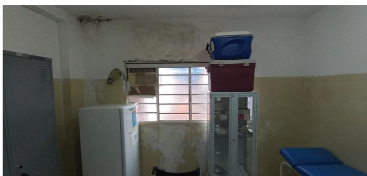
Foto 8 - Sala de vacina repleta de mofo, absolutamente insalubre.
