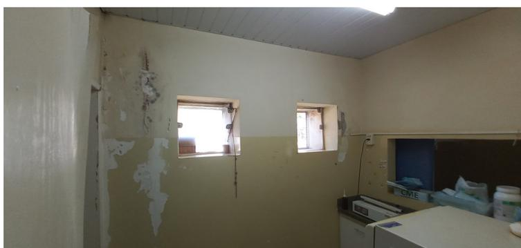
Foto 7 - Sala de esterilização acometida por infiltrações e proliferação de mofo.
