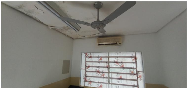
Foto 6 - Sala dos ACS com pintura desgastada e mofo aparente.
