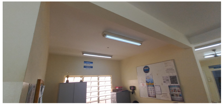
Foto 2 - Recepção sem climatização adequada.
