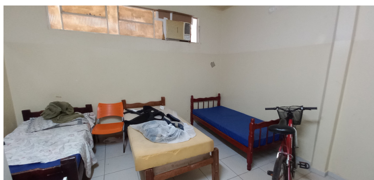
Foto 8 - Colchões disponíveis aos servidores em péssimo estado de conservação.
