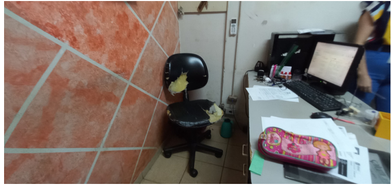
Foto 2 - Mobiliário da unidade extremamente avariado.
