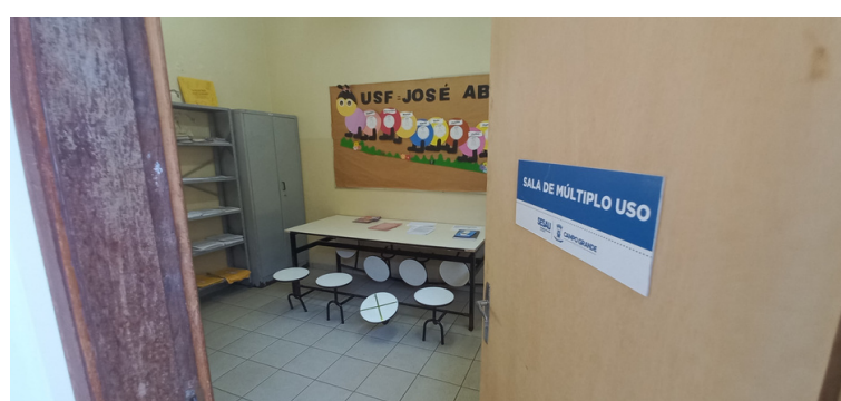
Foto 8 - Sala de multiuso com móveis avariados.
