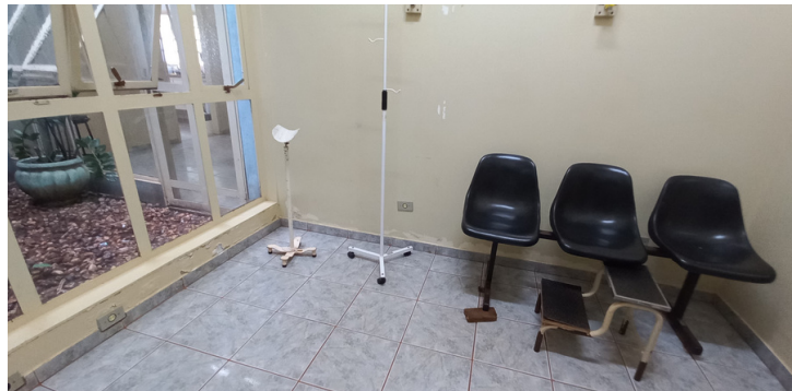
Foto 10 - Mobiliário da repartição avariado.
