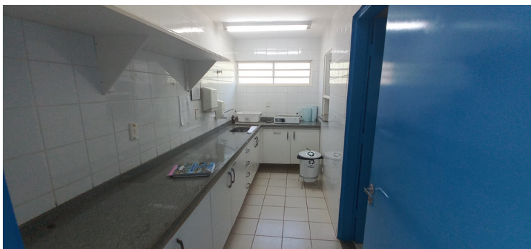
Foto 6 - Setor de esterilização com autoclave danificada.
