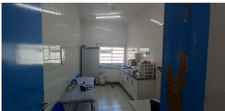
Foto 5 - Sala de coleta sem arrefecimento adequado.
