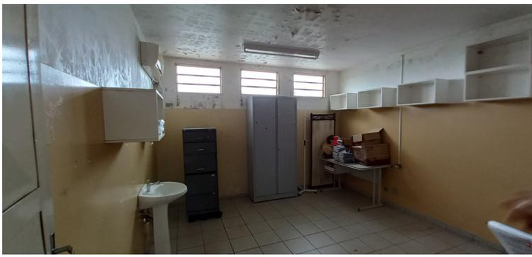
Foto 9 - Sala de enfermagem desativada devido ao bolor nas paredes e pintura deteriorada.
