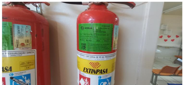
Foto 8 - Extintor de incêndio com validade expirada.
