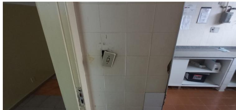
Foto 8 - Interruptores mal instalados.
