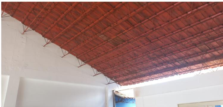
Foto 1 - Necessidade de substituição de algumas telhas.
