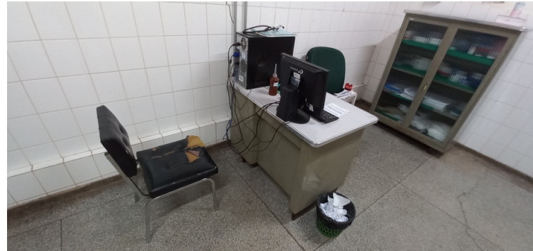
Foto 4 - Consultório médico com mobiliário avariado.
