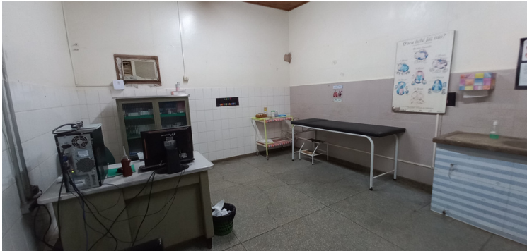
Foto 3 - Consultório médico com ar condicionado antigo.
