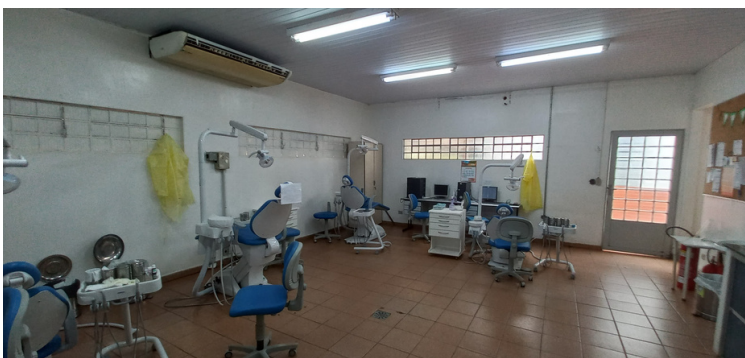
Foto 7 - Setor de Odontologia com ar condicionado antigo.
