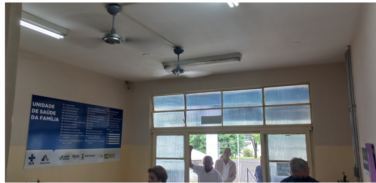
Foto 2 - Recepção da unidade com falta de lâmpadas.
