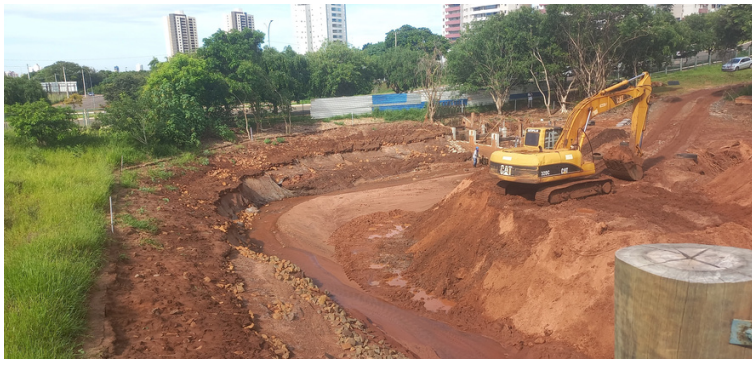
Foto 9 - Obra de desassoreamento da lâmina d'água.
