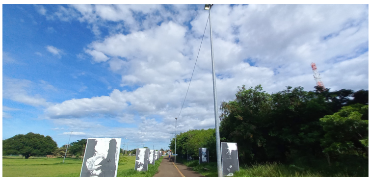
Foto 7 - Instalação de fiação elétrica aérea, para evitar os furtos .
