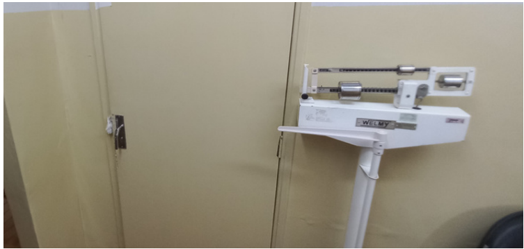
Foto 5 - Fechadura que carece de substituição.
