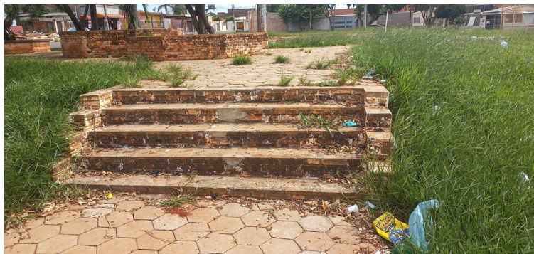
Foto 3 - Área verde sem manutenção.
