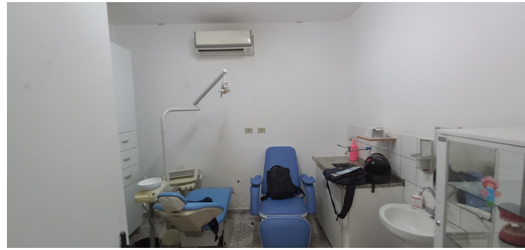
Foto 4 - Setor de Odontologia interditado pela Vigilância Sanitária.
