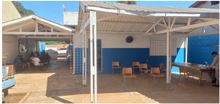
Foto 6 - Sala de reunião em local aberto sem proteção .
