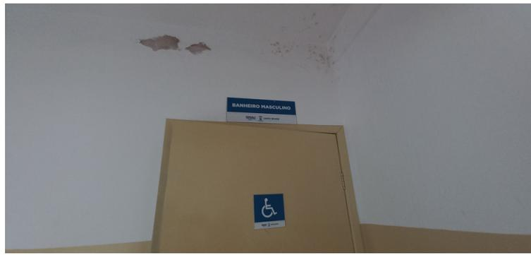
Foto 2 - Paredes com pintura descascada, com infiltração e mofo aparente.
