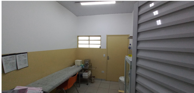
Foto 3 - Sala sem climatização apropriada.
