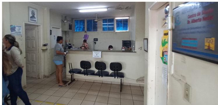
Foto 2 - Recepção desprovida da devida climatização.
