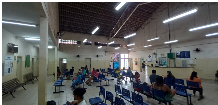
Foto 2 - Recepção com a climatização ineficiente e paredes com acúmulo de fuligem.
