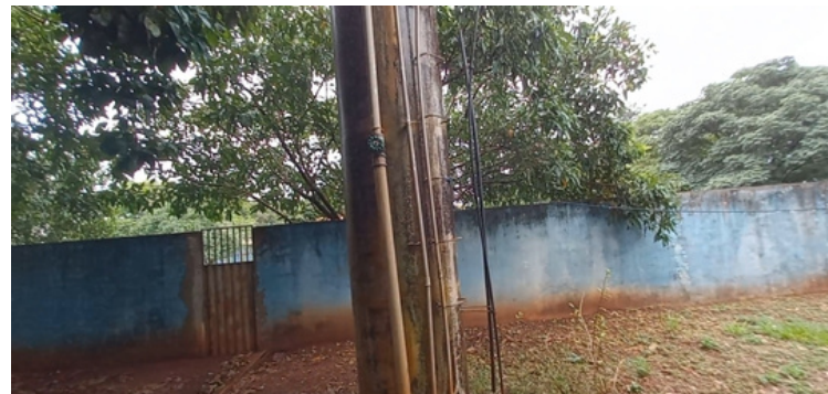
Foto 12 - Caixa d'água com intenso vazamento.
