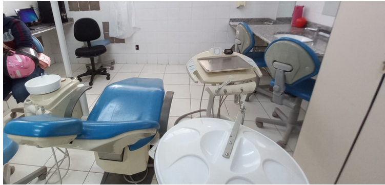
Foto 3 - Cadeira do setor de Odontologia aguardando reparo.
