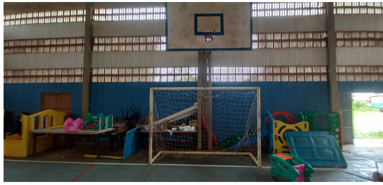
Foto 10 - Quadra de esportes com equipamentos deteriorados.
