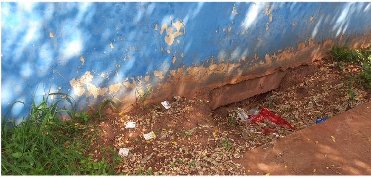
Foto 9 - Muro externo com pontos de erosão.
