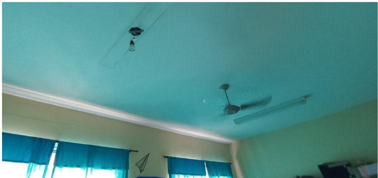
Foto 5 - Lâmpadas queimadas e fiação exposta, aguardando reparo.
