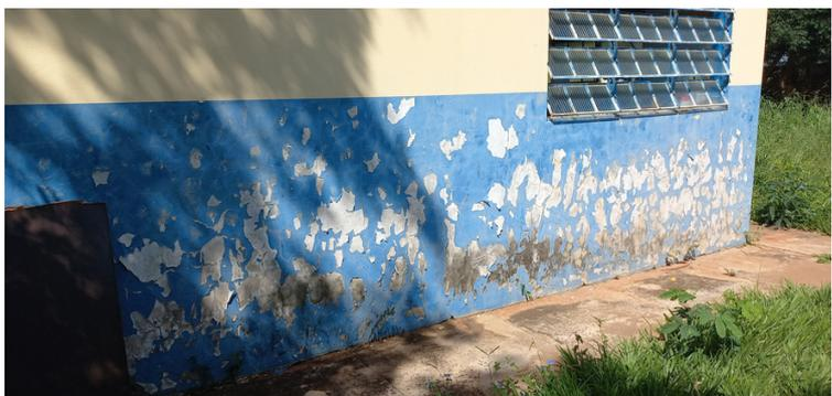
Foto 7 - Pintura externa extremamente desgastada.
