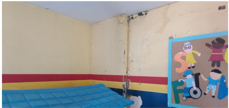
Foto 4 - Pintura desgastada, com infiltração e bolor aparente.
