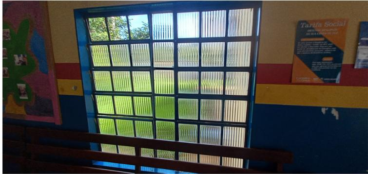
Foto 3 - Vidros quebrados carecendo substituição.
