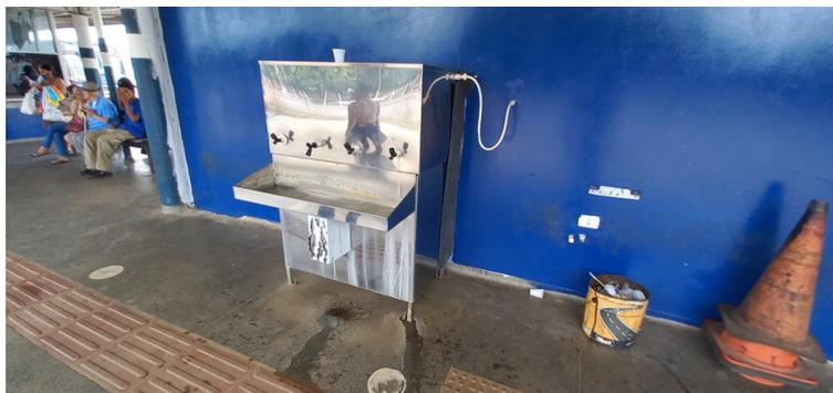
Foto 3 - Bebedouro oferta água potável e gelada, porém com vazamento.
