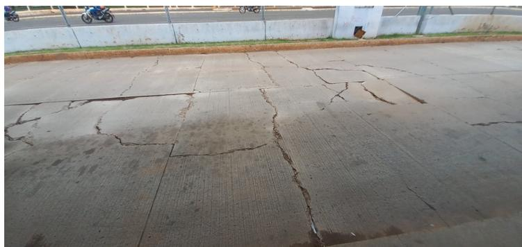
Foto 8 - Pavimento onde trafegam os ônibus com extensas rachaduras.
