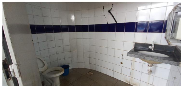
Foto 6 - Sanitário com vazamento na rede hidráulica.
