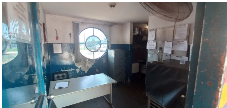
Foto 2 - Sala do administrativo isento da devida comodidade térmica, aparência desagradável e mobiliário insuficiente
