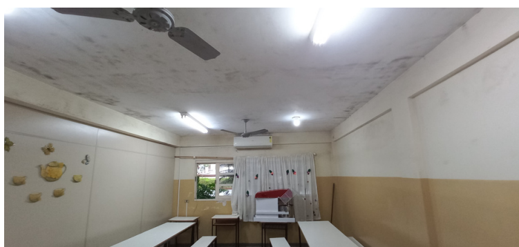
Foto 7 - Refeitório sem a essencial climatização, posto que, os equipamentos de arrefecimento instalados, estão sem a devida funcionalidade.
