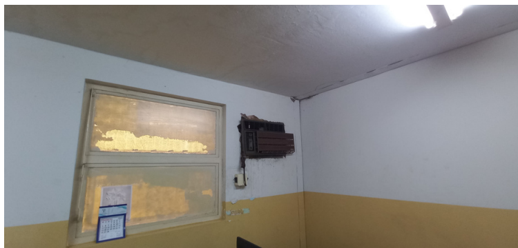
Foto 9 - Equipamento de ar condicionado obsoleto e ineficiente.
