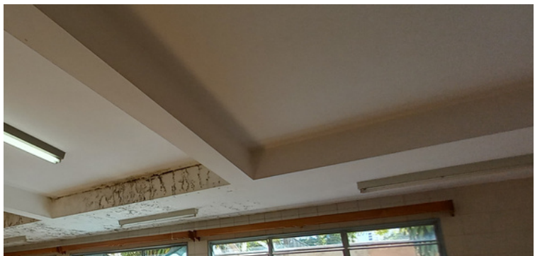
Foto 6 - Lâmpadas queimadas que necessitam de substituição.
