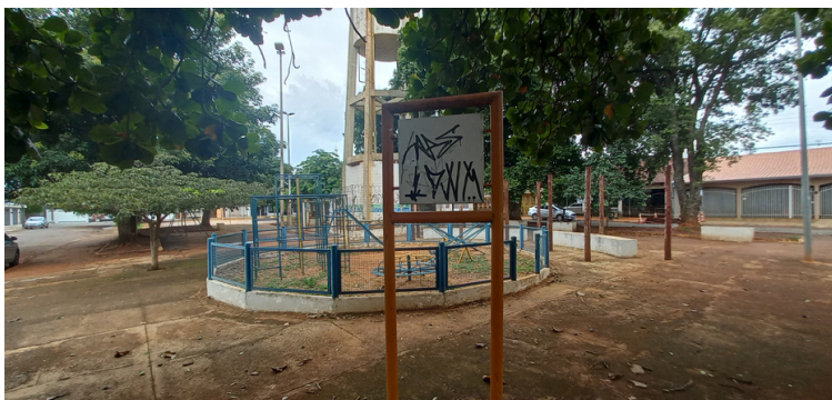
Foto 1 - Placa de identificação da praça depredada.
