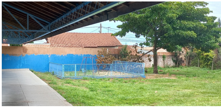
Foto 2 - Parque infantil desativado por falta de manutenção e com brinquedos faltantes.
