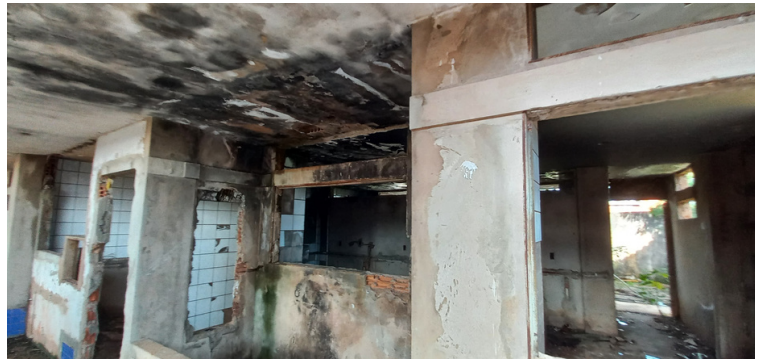
Foto 6 - Infiltrações por toda área e bolor evidente.
