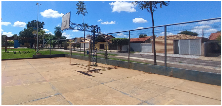
Foto 6 - Quadra poliesportiva com tela de proteção deteriorada.
